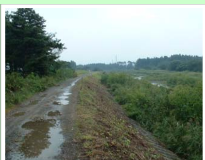
施工前(散策路工)
