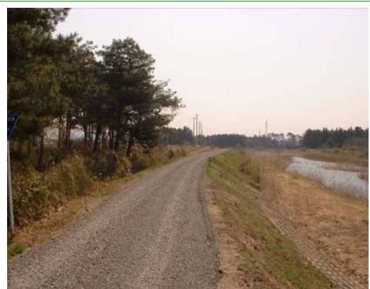
施工後(散策路工)
