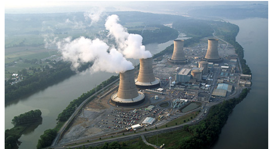
スリーマイル島原子力発電所
