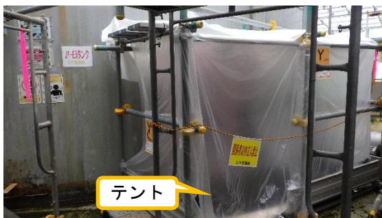
(写真4) J1—E5タンクのテント設置状況
