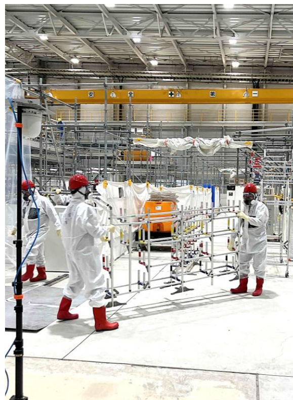
ケーブルラックの設置
