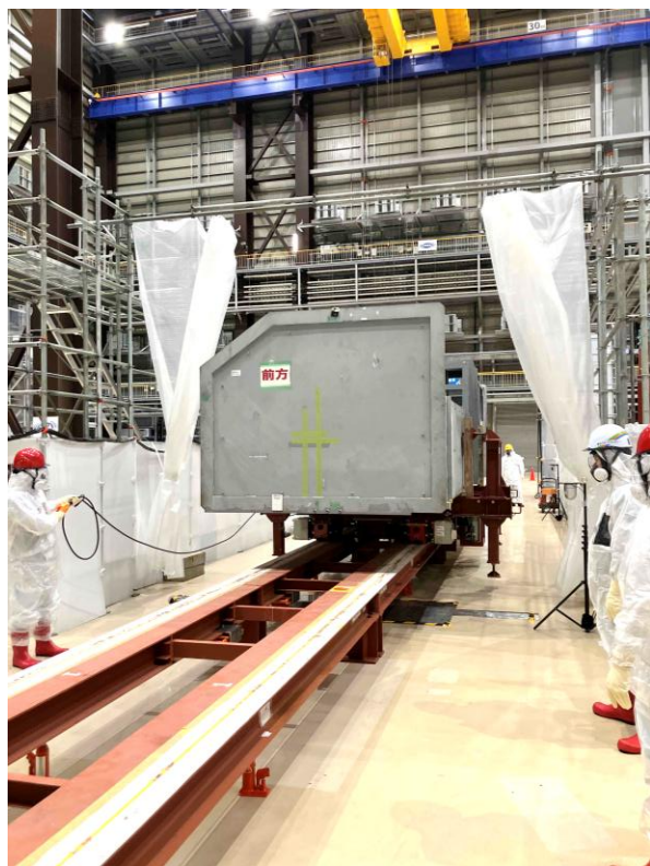
エンクロージャの搬送
