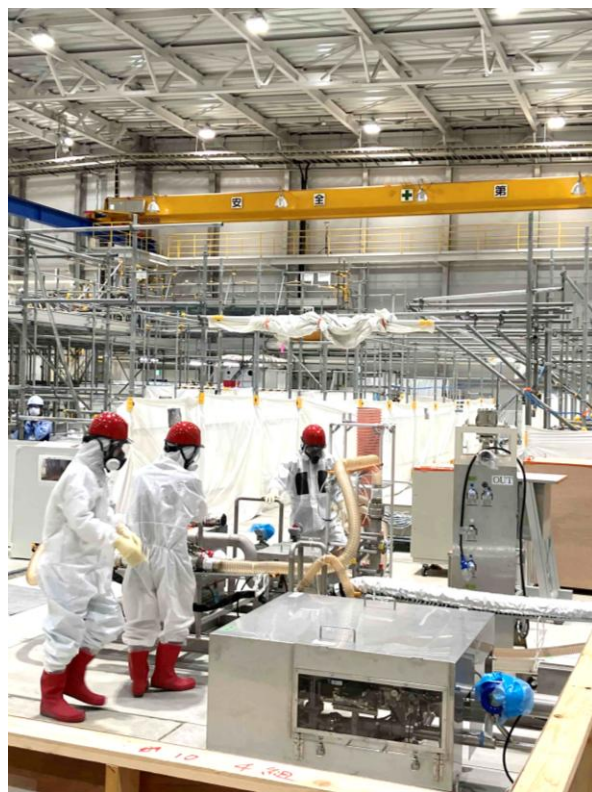
付帯設備の搬送
