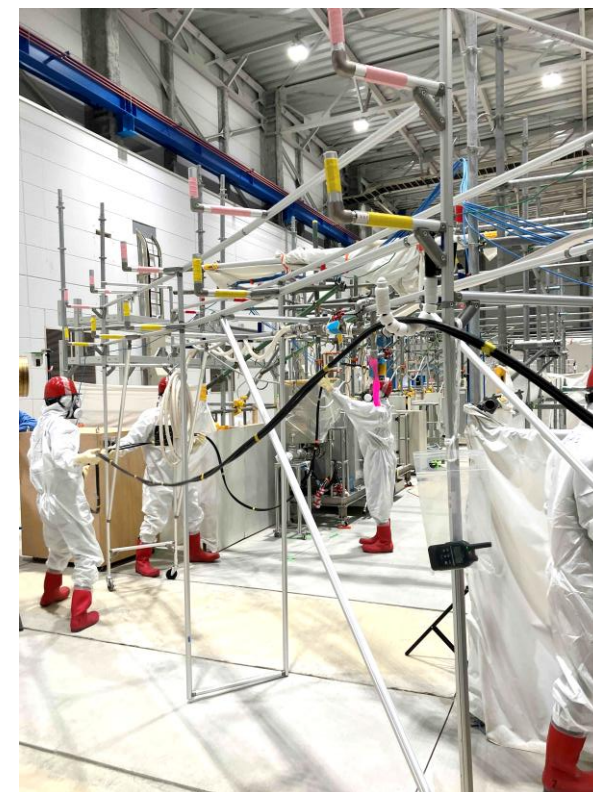
ケーブルの敷設
