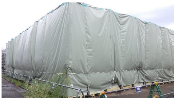
(写真 4 ③) 西側エリアの保管状況① (コンテナへのカバー設置)
