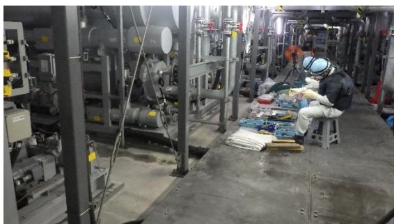
(写真 1 ③) 冷凍機圧力計配管の取替作業状況①
