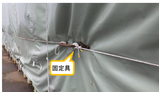
(写真 4 ④) 西側エリアの保管状況② (カバーの固定具)
