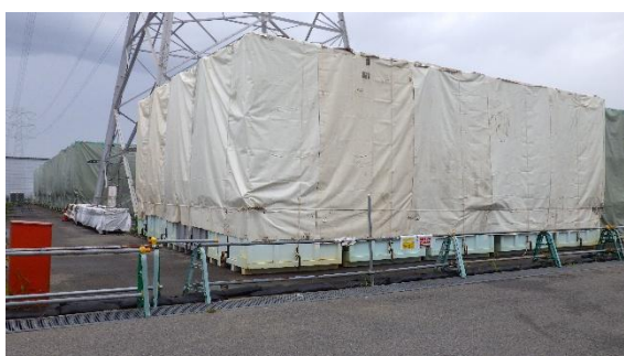
(写真 4 ①) 東側エリアの保管状況① (コンテナへのカバー設置)
