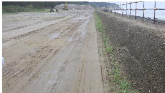
(写真4-3) 北側護岸エリア浚渫土砂置き場の状況③(北側:エリア中央部から撮影) ※今回確認時
