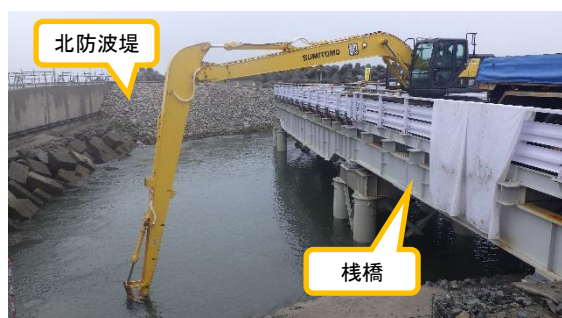
(写真1-1) 5/6号機取水路開渠内浚渫作業の状況①
