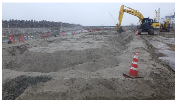
(写真2) 浚渫土砂用ピットの状況
