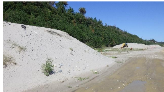
(写真4-4) 北側護岸エリア浚渫土砂置き場の状況④(北側:エリア中央部から撮影) ※前回確認時
