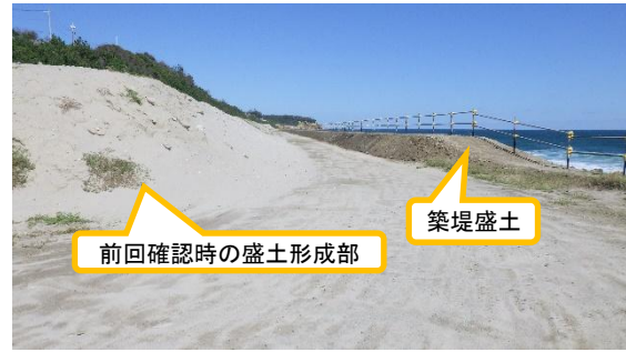
(写真4-2) 北側護岸エリア浚渫土砂置き場の状況②(南側:搬入口付近から撮影) ※前回確認時
