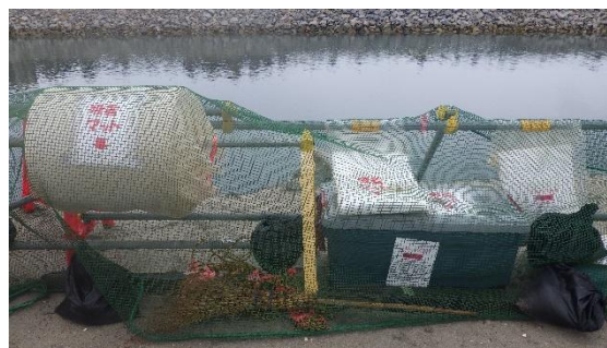
(写真3) 油吸着マット等の設置状況
