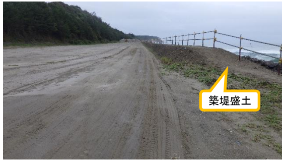
(写真4-1) 北側護岸エリア浚渫土砂置き場の状況①(南側:搬入口付近から撮影) ※今回確認時
