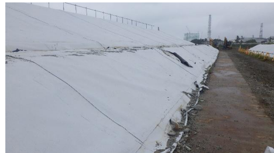
(写真5-2) 瓦礫類一時保管エリアL(第3槽)における遮水シート固定部の撤去状況②
