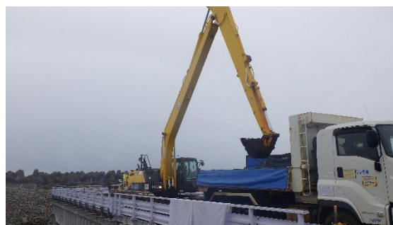
(写真1-2) 5/6号機取水路開渠内浚渫作業の状況②
