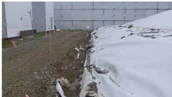
(写真5-1) 瓦礫類一時保管エリアL(第3槽)における遮水シート固定部の撤去状況①
