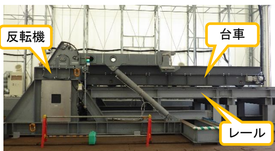
(写真3) 小割テント内部におけるレール、台車及び反転機の設置状況
