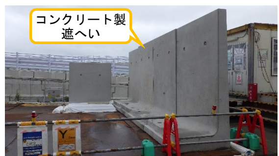
(写真6) 小割テント周囲におけるコンクリート製遮へいの設置状況
