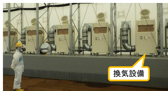
(写真4) 小割テントの内部における換気設備の設置状況
