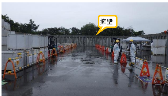
(写真 4) 瓦礫類一時保管エリア A 2 の状況
