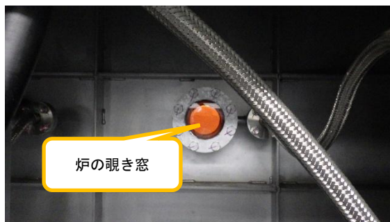
(写真 1－1) 焼却炉の状況①
