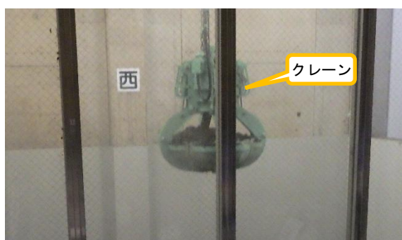
(写真 2－2) クレーンによる伐採木チップの把持 状況
