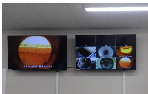
(写真 1－2) 焼却炉の状況② ※中央操作室において監視カメラの 映像を確認した。
