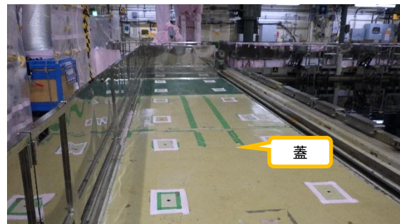
(写真 4) 6号機新燃料貯蔵庫の状況
