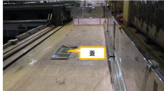
(写真 2) 5号機新燃料貯蔵庫の状況
