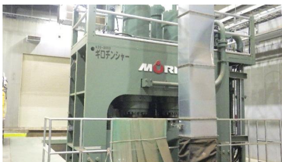
(写真 5 ③) ギロチンシャーの設置状況
