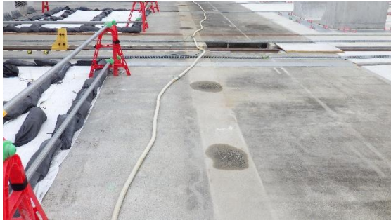
(写真3) 仮保管設備の状況① (既設エリアと増設エリアの境界の周辺防護区域用フェンスの撤去後の状況)
