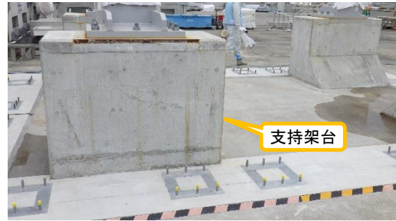
(写真4) 仮保管設備の状況② (エリア西側の増設箇所の兼用キャスクの支持架台の設置状況)
