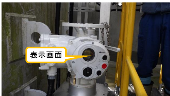
(写真 1－2) 駆動機構の画面表示状況（開度が 0%の表示）
