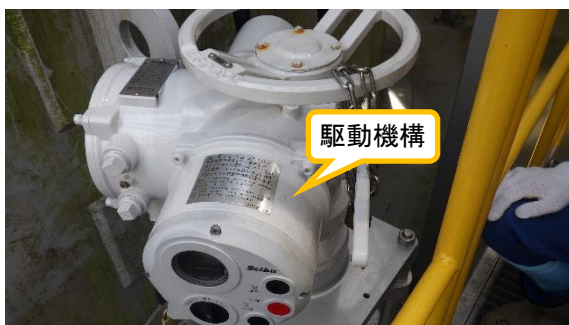
(写真 1－1) 連結弁の改造状況
