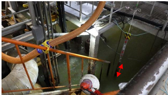
(写真4-1) 6号機タービン建屋の滞留水の状況 (前回撮影)
