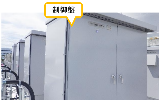
(写真 2－2) 制御盤の設置状況
