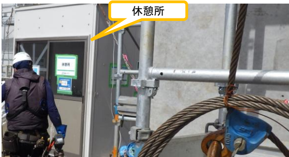
(写真 2-2) 2 階に設けられた休憩所の設置状況
