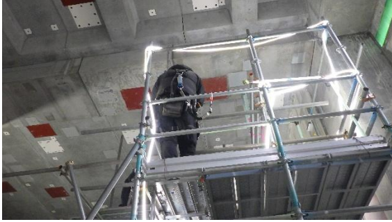
(写真 2-1) 作業員の作業状況（空調服及びフルハーネス型墜落制止用器具の着用）
