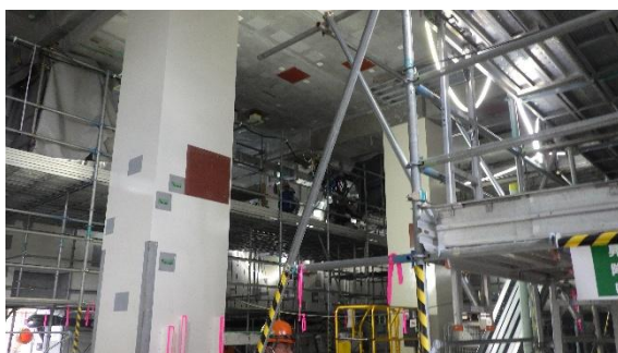
(写真 1-2) 換気空調設備設置用の足場設置状況
