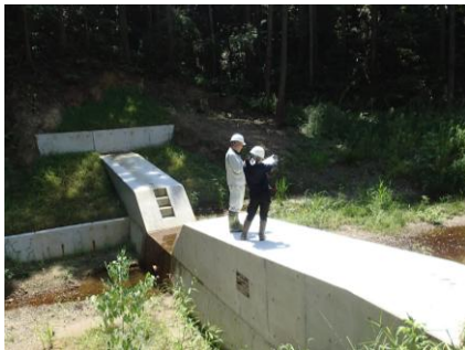
▲治山施設の視察 (森林林業部)
