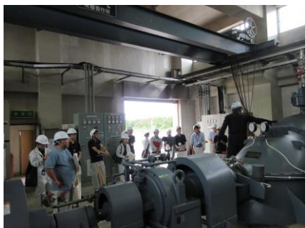
▲排水機場の概要説明
