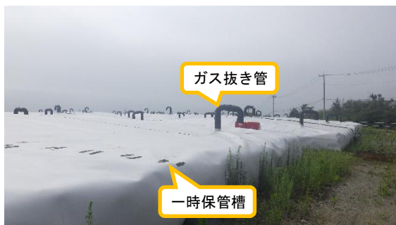
(写真 1 - 1) 伐採木一時保管エリアG南 東側 ※今回確認時
