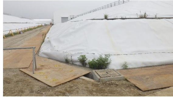
(写真 6－2) 瓦礫類一時保管エリア L (敷鉄板の敷設)
