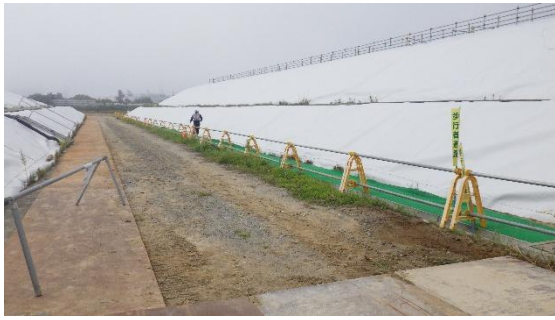
(写真 6－1) 瓦礫類一時保管エリア L (作業用通路の設置)
