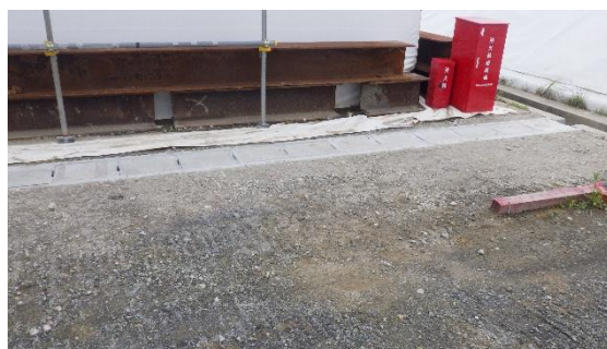
(写真 5 - 2) 瓦礫類一時保管エリアL (小テント前に敷設されたU字溝) ②
