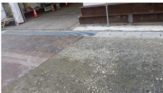
(写真 5 - 1) 瓦礫類一時保管エリアL (小テント前に敷設されたU字溝) ①
