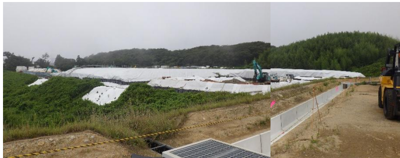
(写真 7) 瓦礫類一時保管エリア C の全景 (エリア北側より撮影)
