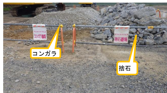
(写真3②) 瓦礫類の仮置き状況
