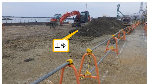
(写真3①) 土砂の仮置き状況
