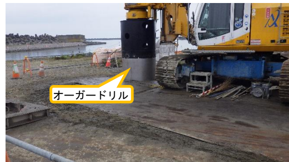
(写真2) 掘削作業の状況
