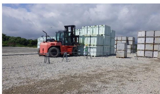
(写真 5 - 2) 伐採木一時保管エリアH（東側エリア 中央部）の状況②（今回確認時）
