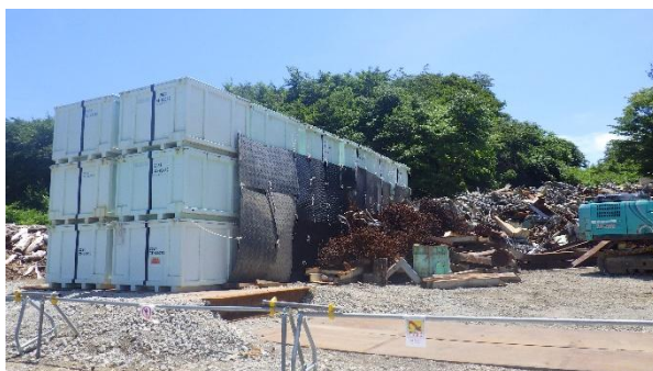
(写真 1－1) 伐採木一時保管エリアM南西側の状況 ① (前回確認時)
