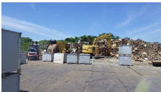
(写真 6－１) 伐採木一時保管エリアH（東側エリア 南側）の状況①（前回確認時）
