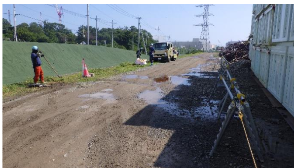
(写真 3 - 1) 除草作業の状況
