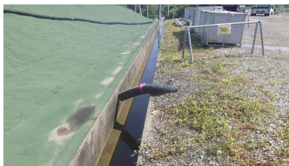
(写真 3 - 2) 側溝の状況
