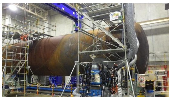
(写真 1-1) 使用済みブルータンク (3基目)の搬入・付属品撤去作業
