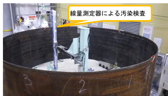
(写真1-6) 使用済みブルータンク (1基目)の汚染検査作業
