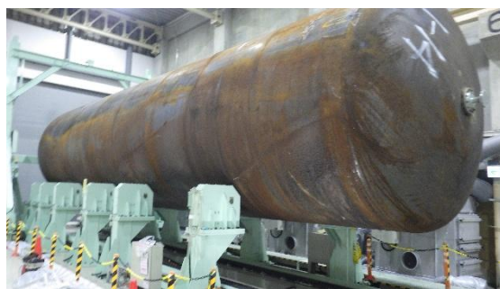
(写真 1-2) 使用済みブルータンク (2基目)の切断作業
