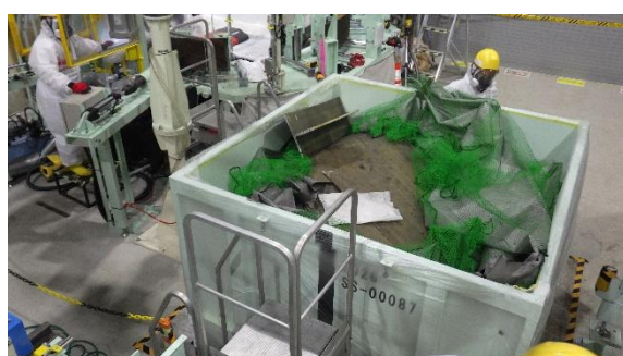
(写真1-7) 使用済みブルータンク (1基目)の剥離後FRPの収納作業
