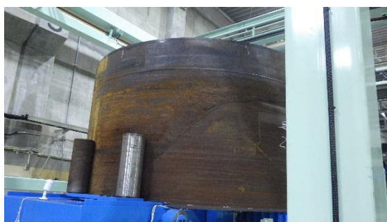
(写真 1-3) 使用済みブルータンク (1基目)の反転・運搬作業
