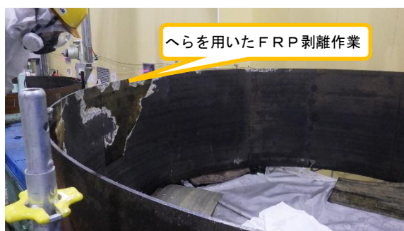
(写真1-5) 使用済みブルータンク (1基目)のFRP剥離作業
