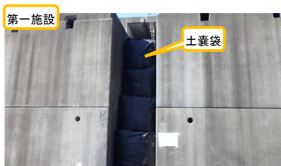
(写真 2) 遮へい用土嚢袋の設置状況
