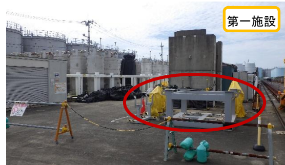
(写真 4 ②) HIC 吊上用治具の点検②
