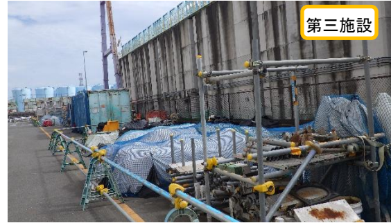
(写真 7 ②) 第三施設西側エリアの 増設工事用資機材が整理状況②
