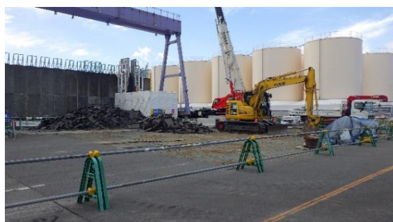
(写真 5 ①) 増設工事の状況① (令和 8 年 1 月 2 0 日撮影)
