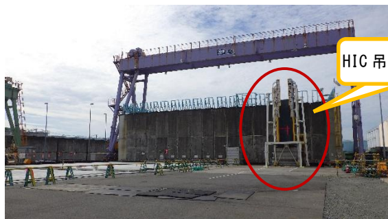
(写真 5 ③) 増設工事の状況③ (今回撮影) 増設エリアは、全て整地 されている。
