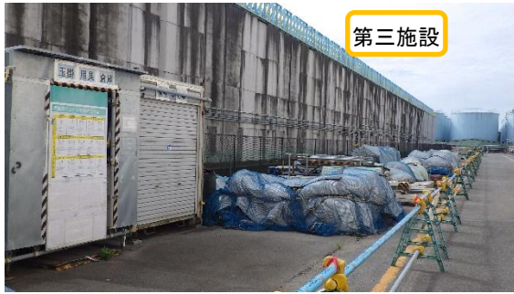
(写真 7 ①) 第三施設西側エリアの 増設工事用資機材が整理状況①
