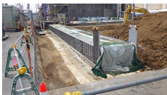
(写真 6 ①) 東側のレーン延伸状況① (令和 8 年 4 月 1 5 日撮影)
