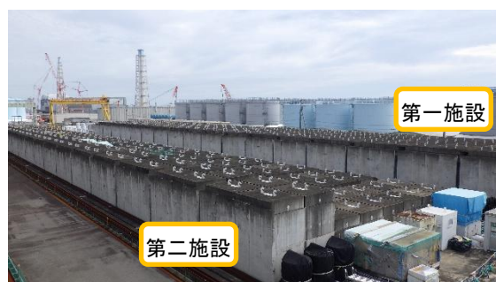
(写真 3 ②) ボックスカルバートに よる保管状況の鳥瞰①
