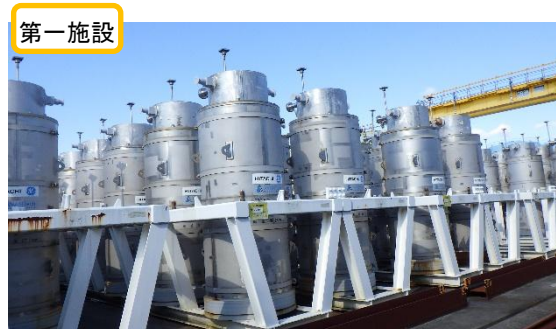
(写真 1 ②) 架台による保管
