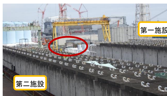
(写真 4 ①) HIC 吊上用治具の点検①
