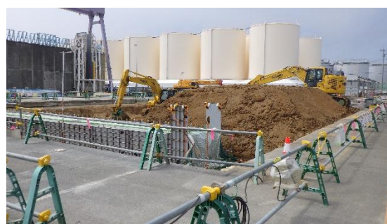
(写真 5 ②) 増設工事の状況② (令和 8 年 4 月 1 5 日撮影)
