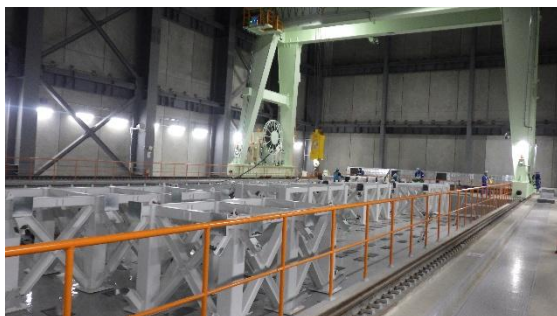
(写真 1－2) 架台部材の仮置き状況
