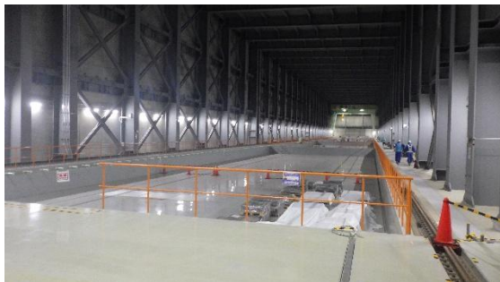
(写真 1－1) 大型廃棄物保管庫内部の状況
