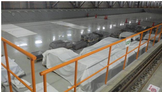
(写真 3) 資材の仮置き状況
