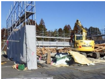
建物解体の様子
