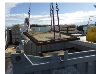
解体、コンテナ詰め
