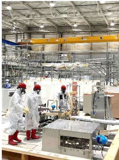
付帯設備の搬送
