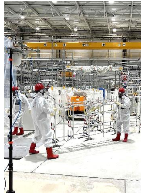
ケーブルラックの設置
