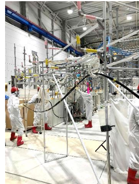
ケーブルの敷設
