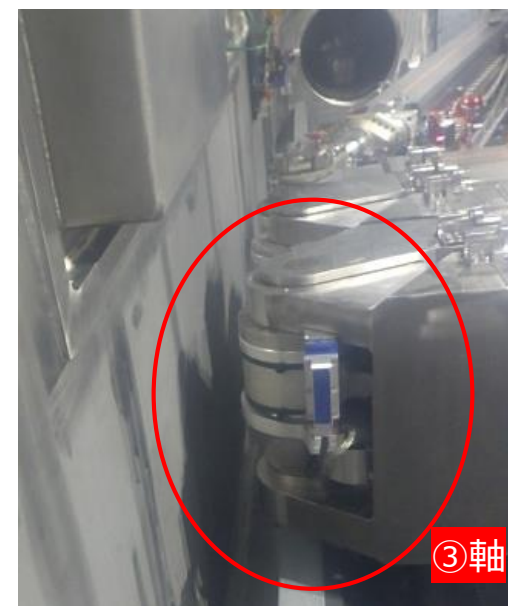
エンクロージャ内確認状況
