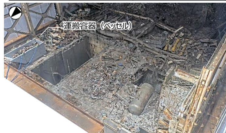
ガレキ撤去 開始後（撮影：2026年8月29日）
