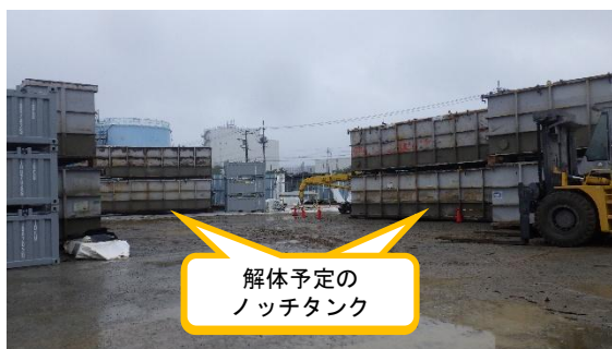
(写真5) エリアDD西側に搬入された解体予定のノッチタンク群
