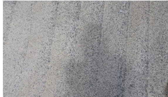
(写真 7-2) 除染済の箇所の状況 縦に削った跡が確認できる。 ※令和 8 年 6 月 19 日撮影
