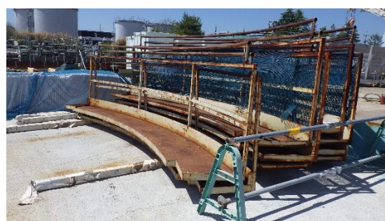
(写真6-4) タンク解体部材の整理 ※令和8年5月28日撮影
