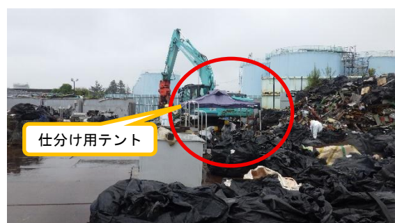
(写真 4－2) エリアD D東側における作業状況② (廃棄物の分別)
