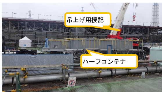
(写真1-2) 詰替えた汚染土壌の輸送用ハーフコンテナと重機配置状況
