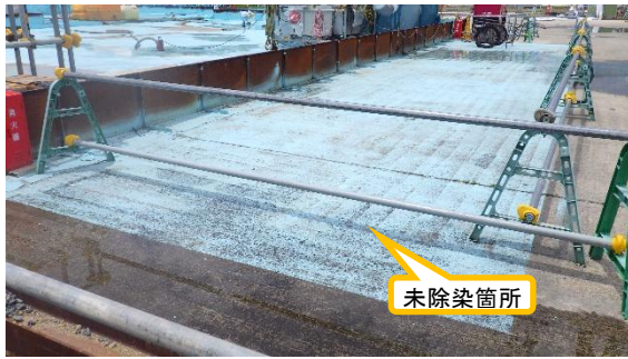
(写真 7-1) 未除染の箇所の状況 青色の印を付けている。 ※令和 8 年 6 月 19 日撮影
