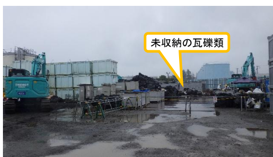
(写真 4－1) エリアD D東側における作業状況① (全景)
