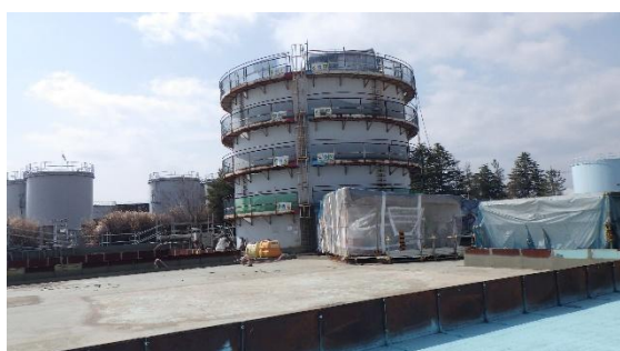
(写真6-1) フランジ型D1タンクの全景 ※令和8年3月25日撮影
