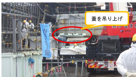
(写真1-1) 一時保管エリアN内における詰替え作業の状況（ノッチタンクの蓋を開放し、揚重作業を実施）
