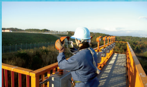
航空灯火の点検
