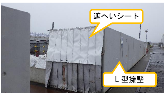
(写真 3－2) 滞貨ヤードにおける L 型擁壁及び遮へいシートの設置状況
