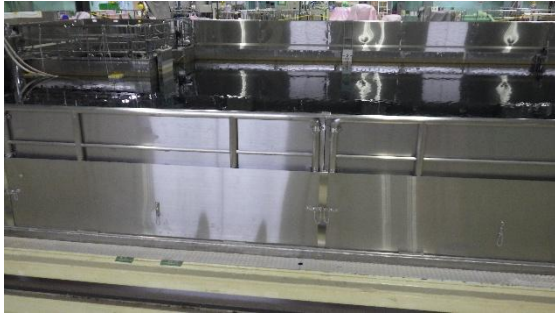
(写真 1－1) 共用プールの状況①
