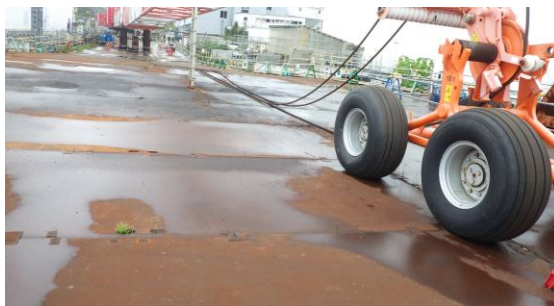
(写真5) 中割ヤードの状況 ※中割ヤード内は鉄板が敷かれて いる
