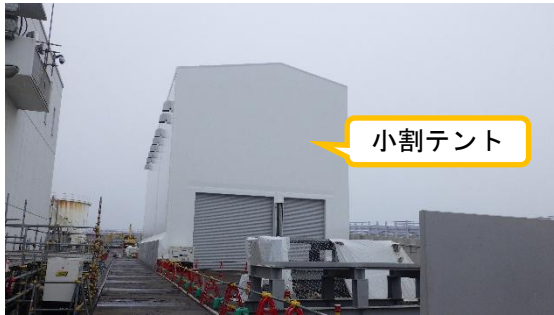
(写真4) 小割tentの設置状況
