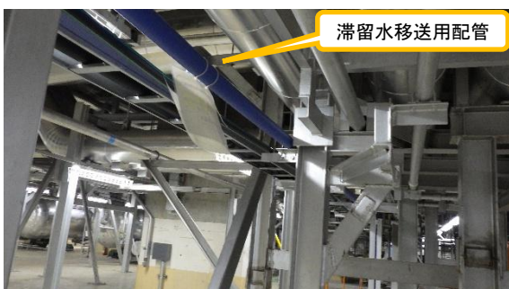
(写真 2－1) 6号機タービン建屋地下階における 滞留水の状況 (前回確認時)
