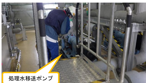
（写真３）処理水移送ポンプの動作確認の状況（聴診を実施）
