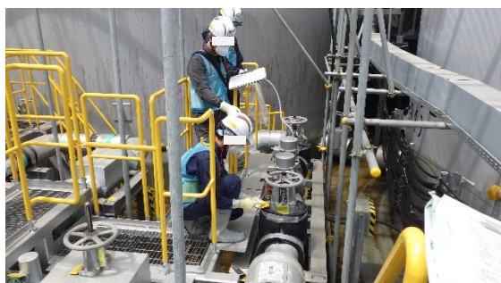
(写真 1 - 1) 指差呼称による弁の開閉確認の状況
