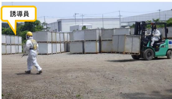
(写真 2－2) コンテナの運搬状況
