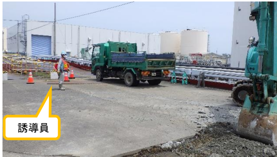
(写真 6－2) 誘導員の配備状況
