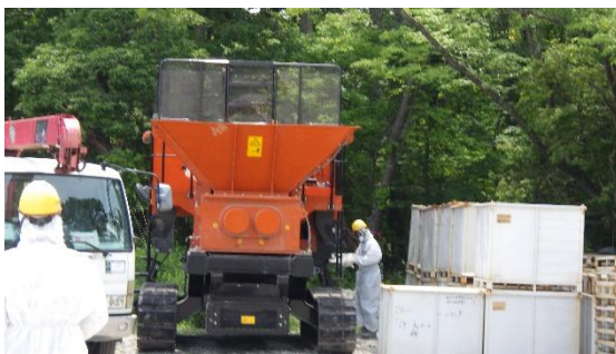
(写真 2－3) 破砕機の設置状況
