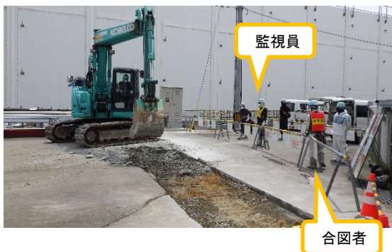
(写真6－1) 監視員及び合図者の配備状況
