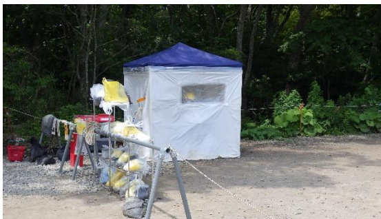
(写真4) クーラーハウスの設置状況
