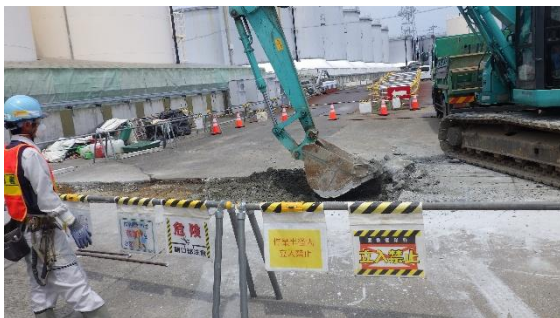
(写真5) 掘削作業の状況
