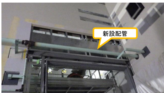
(写真 1 ③) 地下階の配管敷設の状況
