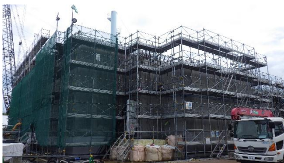
(写真 1 ①) 第 2 棟の外観
