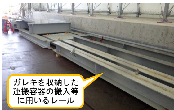
（写真5）小割テントにおけるレールの搬入状況
