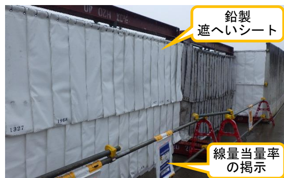
（写真2）滞貨ヤードの周囲に設置された鉛製遮へいシートの状況 （線量当量率掲示値：35 \mu Sv/h）
