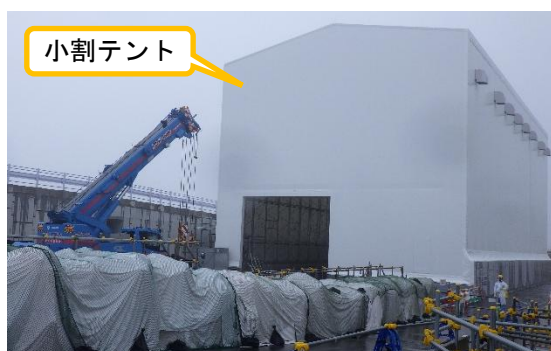
（写真3）小割テントの設置状況（1号機タービン建屋東側）
