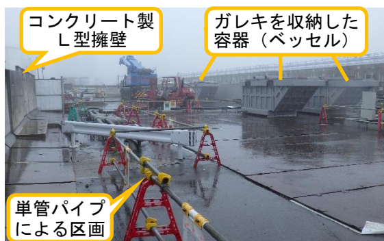
（写真1）滞貨ヤードにおけるガレキを収納した運搬容器（ベッセル）の保管状況
