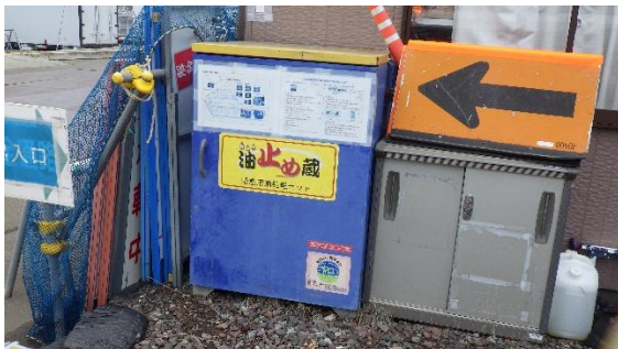
(写真 3－2) 油漏れ対策キットの設置状況
