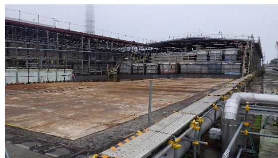
(写真 2－2) エリアNの状況（西側） （今回確認時）
