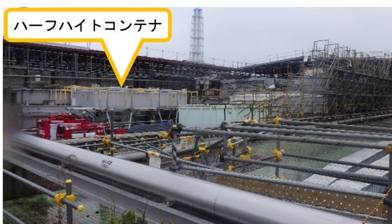
(写真 2－1) エリアNの状況（西側） （前回確認時）
