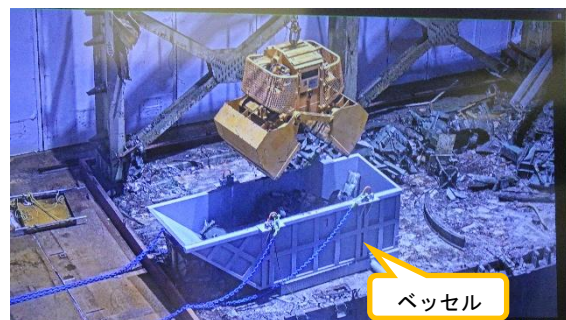
(写真2②) 遠隔操作室におけるガレキ撤去作業のモニタ状況④
