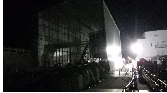
(写真 3 ②) 小割テントの状況
