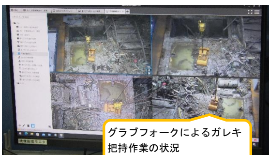
(写真2①) 遠隔操作室におけるガレキ撤去作業のモニタ状況③
