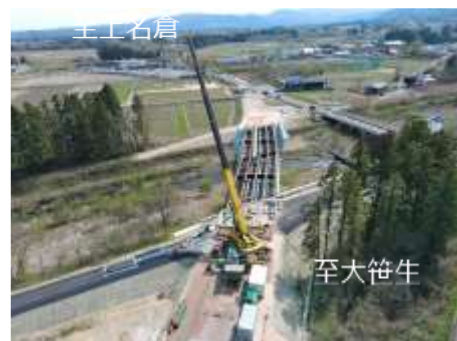
県道上名倉飯坂伊達線 天戸橋工区
