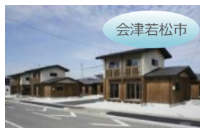
復興公営住宅：戸建
