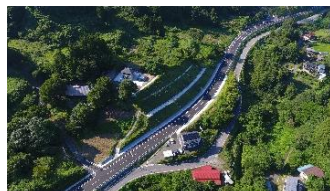
国道349号 (大綱木工区) 2023年3月21日 完成
