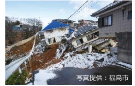
家屋被害：福島市
