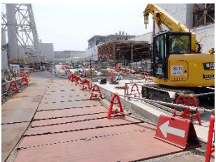
フェーシング前 (3号機付近)
