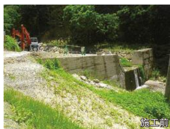
山舟生川（堰堤改築） 伊達市
