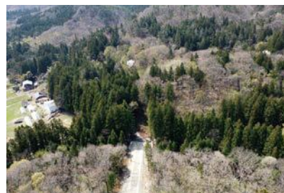
【(須川流域) 小坂沢第1砂防堰堤】 R 8年度工事内容: 堰堤工
