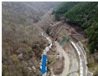
【(荒川流域) 塩の川第8砂防堰堤】 R 8年度工事内容: 堰堤工
