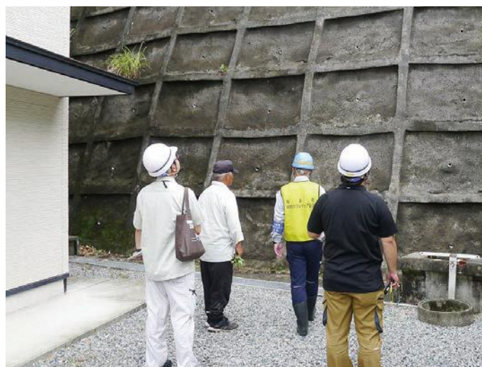
急傾斜地崩壊危険区域の点検 (南相馬市藤谷地区)
