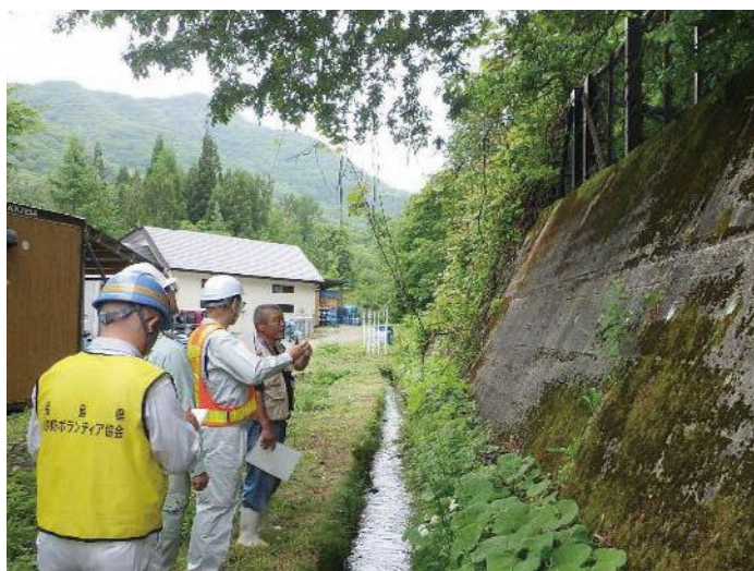
重力式待受擁壁の点検 (猪苗代町高森地区)
