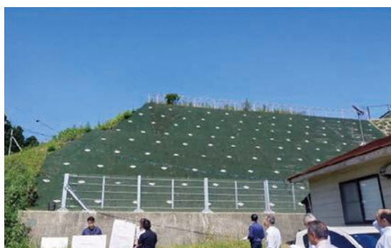
現地視察状況（薬師堂地区急傾斜地崩壊対策施設）
