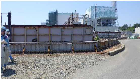
(写真４－２) F２タンクエリアＢ群タンクの外観
