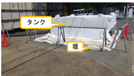
(写真2) コンテナ内包水を受け入れたタンクの 仮置き状況
