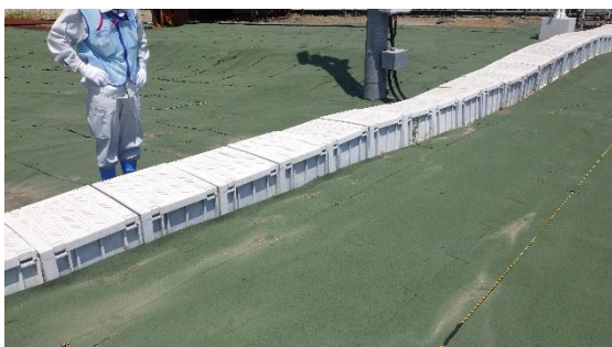
(写真５) ５・６号機滞留水移送配管の状況
