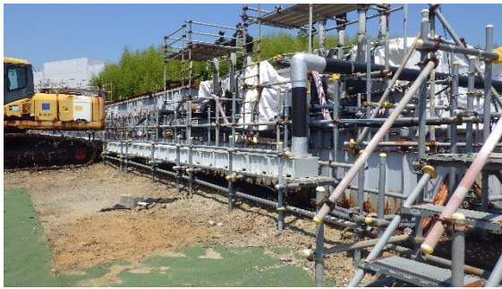
(写真４－１) F２タンクエリアＡ群タンクの外観
