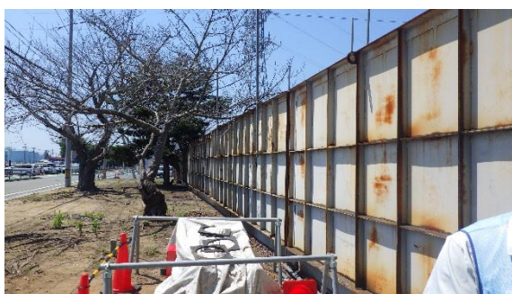
(写真1) コンテナの設置状況
