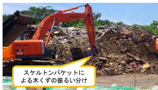
(写真 3－2) 東エリア南側における木くず類の選別状況②
