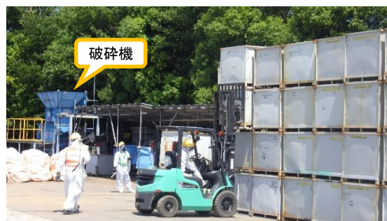
(写真 1－2) 東エリア北側の状況② (瓦礫類の選別作業)
