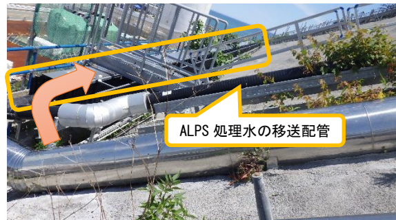
(写真 6－4) A L P S 処理水の移送ルート確認状況⑥ (移送配管は、保護カバーで覆われている)
