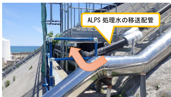
(写真 6－3) A L P S 処理水の移送ルート確認状況⑤ (5号機脇の斜面から海側へ)
