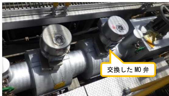
(写真 5－1) A L P S 処理水の移送ルート確認状況① (交換済の払い出し弁)
