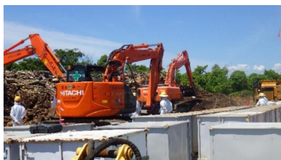
(写真 3－1) 東エリア南側における木くず類の選別状況①
