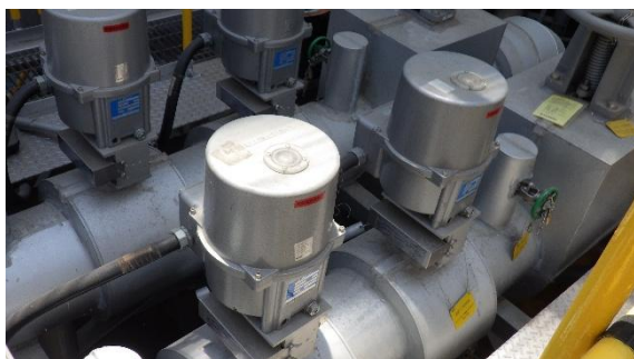
(写真3-3) ALPS処理水測定・確認用タンクB群の払出し弁の交換作業状況③ (類似弁の設置例)
