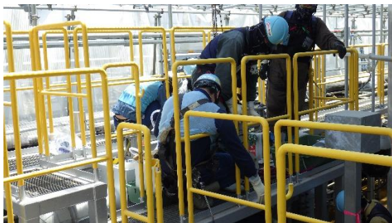
(写真3-1) ALPS処理水測定・確認用タンクB群の払出し弁の交換作業状況① (不具合弁の確認作業)
