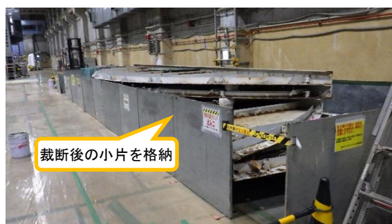
(写真1-2) D1タンク解体片の保管状況②(裁断機・バンドソーによる裁断後の小片の収納)
