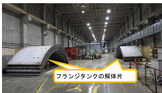
(写真1-1) D1タンク解体片の保管状況①(裁断機・バンドソーによる裁断前の保管状況)
