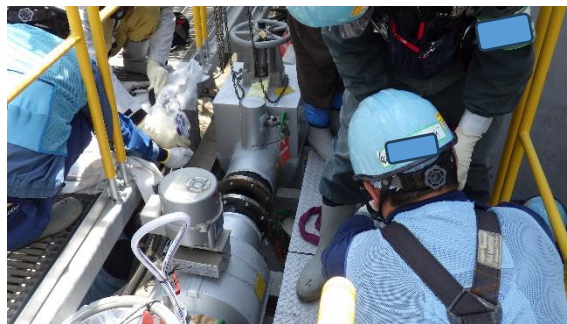
(写真3-2) ALPS処理水測定・確認用タンクB群の払出し弁の交換作業状況② (不具合弁を取出し)
