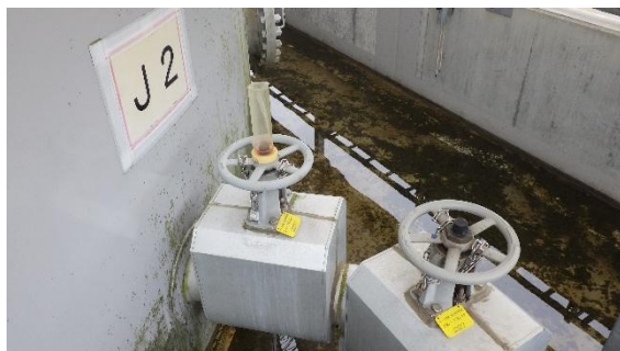
(写真2) J2タンク払出弁の状況
