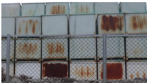
(写真5) 錆が生じているコンテナの 状況
