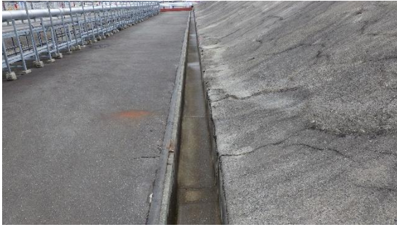
(写真 6－1) エリア J 内の側溝の状況 ※西側から撮影
