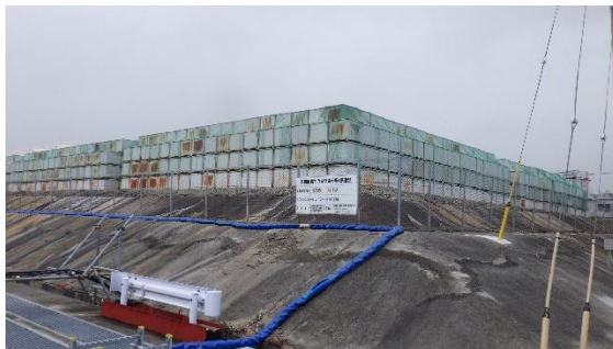
(写真4-1) エリア J の外観 ※北東側から撮影
