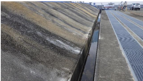
(写真 6－2) エリア J 内の側溝の状況 ※南側から撮影
