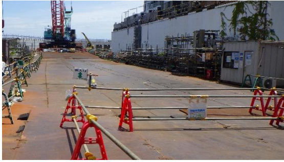
(写真 4) 中割ヤードが設置される区画 (1号機北側)
