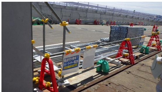
(写真 3－1) 小割テント設置作業エリアに仮置き された資機材
