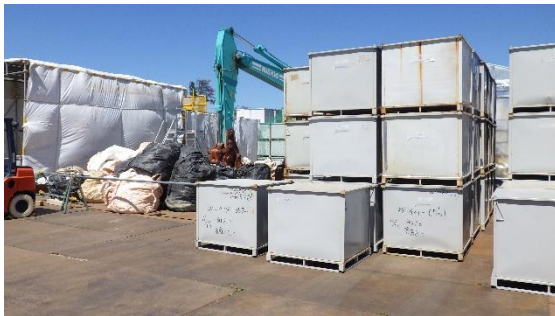
(写真 5 - 1) 一時保管エリア F 西側の状況
