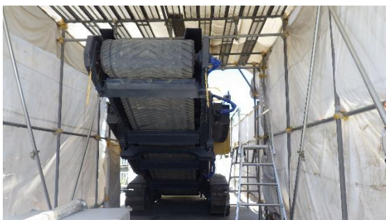
(写真 6 - 1) 破碎機の設置状況
