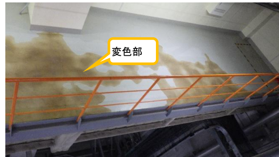
(写真 2－2) 廃棄物貯留ピットの床面 (変色部分は、清掃済み)
