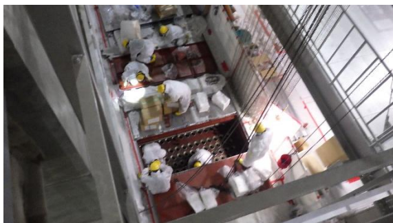
(写真 4－3) 焼却炉内の詳細点検① (バグフィルタの交換作業①)
