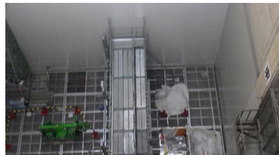
(写真 3－2) 廃棄物貯留ピット内底部における 足場の設置状況②
