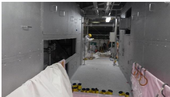
(写真 4－1) 安定運転に向けた対策① (灰移送ルート取り付け)
