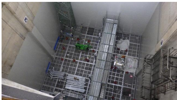
(写真 3－1) 廃棄物貯留ピット内底部における 足場の設置状況①
