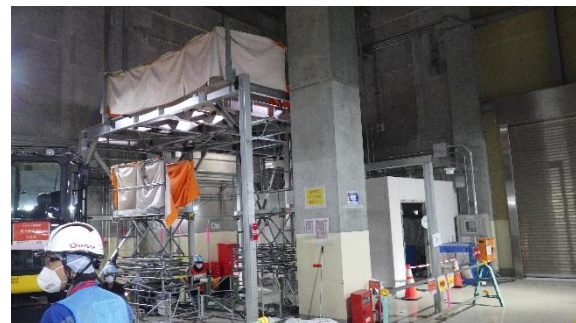
(写真 4－2) 安定運転に向けた対策② (灰詰めハウス設置)
