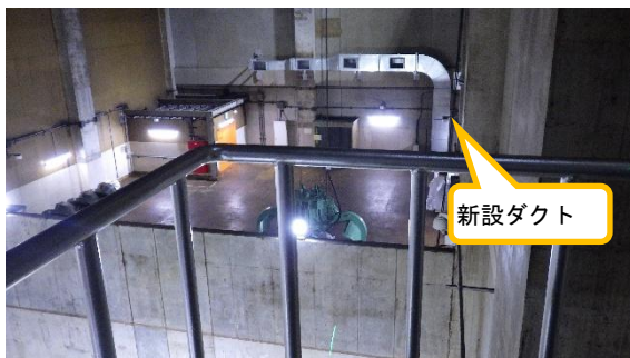
(写真 1 - 3) ピットから廃棄物を取り出す把持用 クレーンの設置場所①
