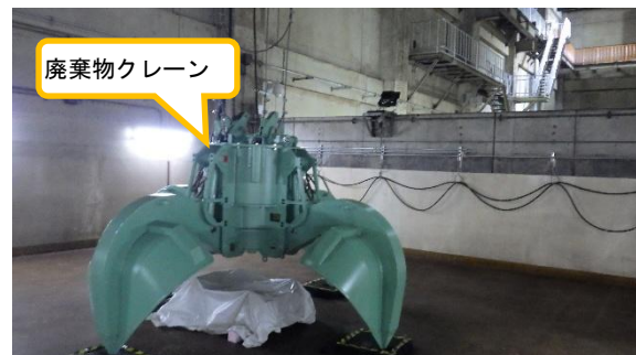
(写真 1 - 4) ピットから廃棄物を取り出す把持用 クレーンの設置場所②
