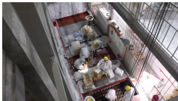
(写真 4－4) 焼却炉内の詳細点検② (バグフィルタの交換作業②)
