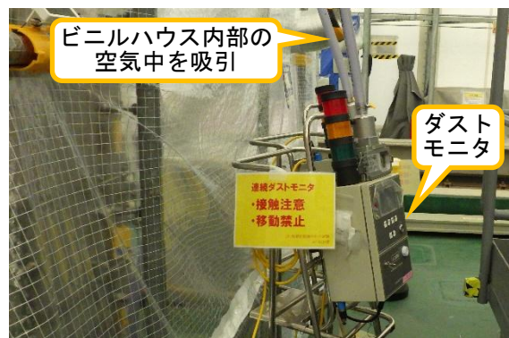
(写真6) ビニルハウス内部の空気中の放射性ダスト濃度を測定するダストモニタの設置状況
