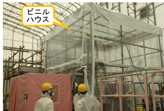
(写真 4) 凝縮水タンク等を収容するビニルハウスの設置状況
