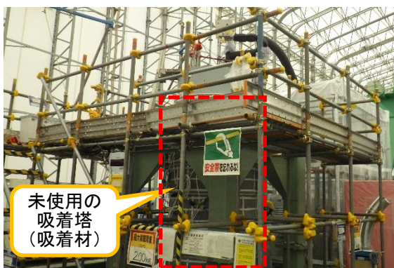
(写真 3) 未使用の吸着塔を用いた吸着材乾燥試験の準備状況
