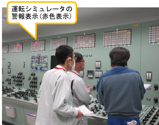
(写真5) 県職員による運転シミュレータ室の設備の確認状況
