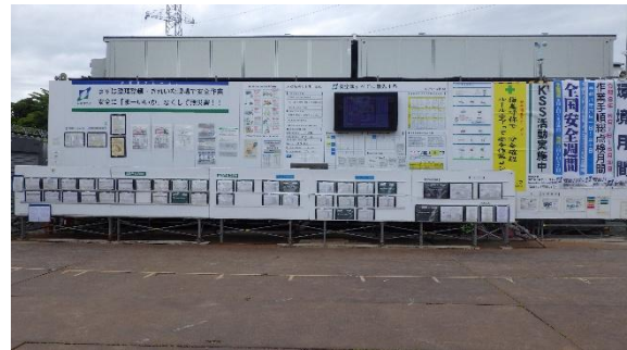
(写真2①) 安全対策の掲示
