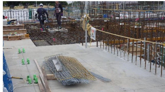
（写真1②）第2棟（2階床面北側）の工事状況
