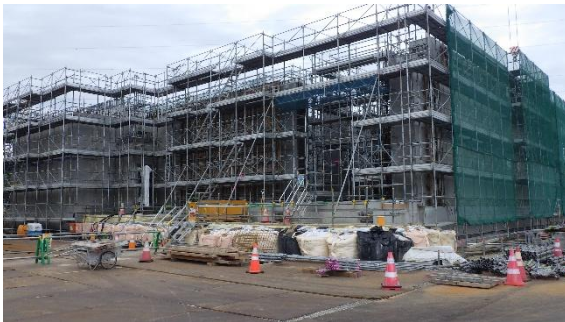
（写真1①）第2棟の外観
