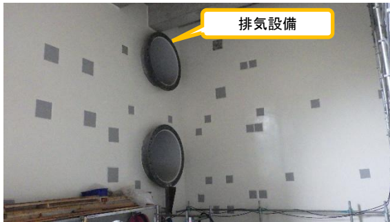
(写真1③) 第2棟(地下階)の工事状況
