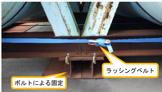
(写真4) タンクの固定
