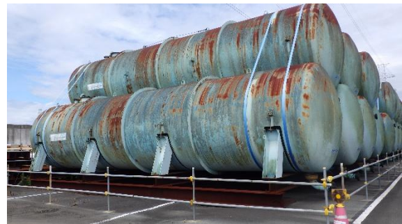
(写真3) ブルータンクエリアA
