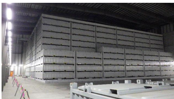
(写真1③) C棟におけるコンテナの保管
