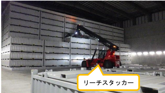
(写真 3) コンテナの積み上げ作業
