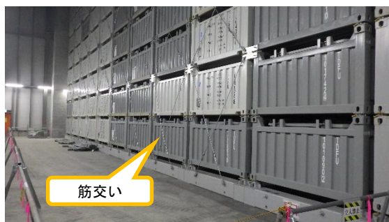
(写真1④) 保管中のコンテナ
