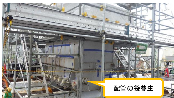
(写真2) 主変圧器部品の仮置き状況
