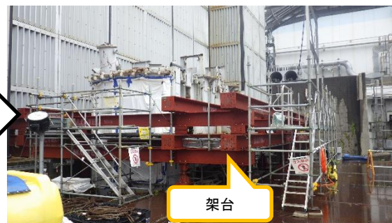
(写真1-2) 主変圧器撤去の状況② ※令和8年6月26日撮影
