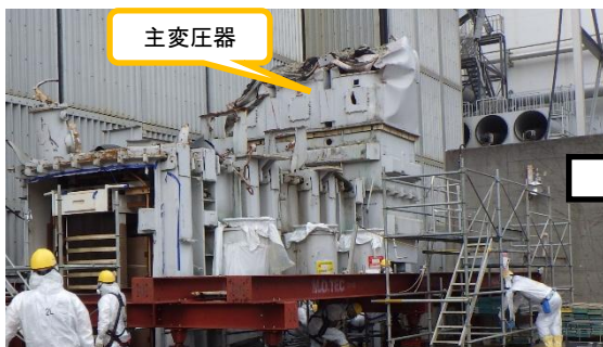
(写真1-1) 主変圧器撤去の状況① ※令和8年4月10日撮影
