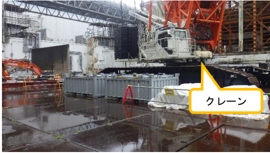
(写真3) クレーンの設置状況
