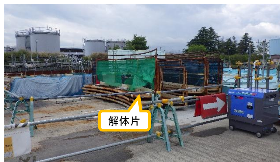
(写真 1 - 2) タンク解体片の仮置き状況
