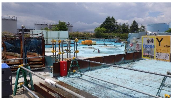
(写真 1 - 1) Eタンクエリアの状況
