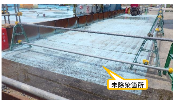
(写真 2 - 1) 未除染の箇所の状況 青色の印を付けている。
