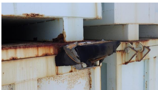
(写真 5) コンテナの補修状況
