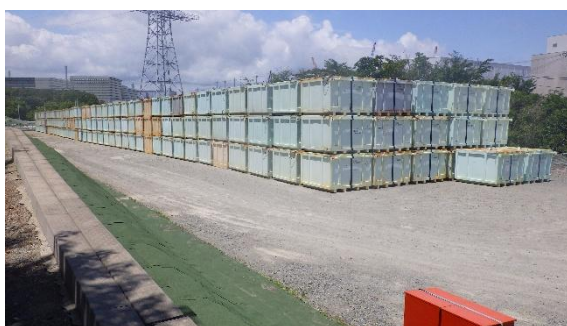
(写真 4—1) 瓦礫類一時保管エリアⅠの状況① (北東側から撮影)
