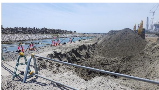
(写真 2) 浚渫土砂用ピットの状況
