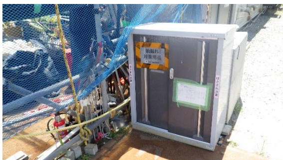
(写真 3) 油漏れ対応品の保管状況
