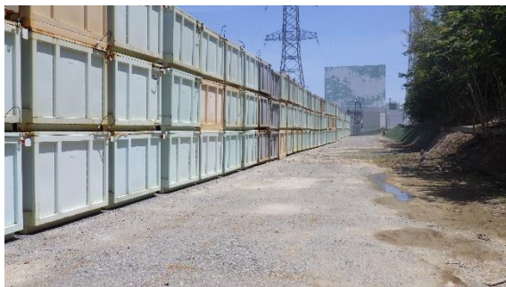
(写真 4－2) 瓦礫類一時保管エリアⅠの状況② (南東側から撮影)
