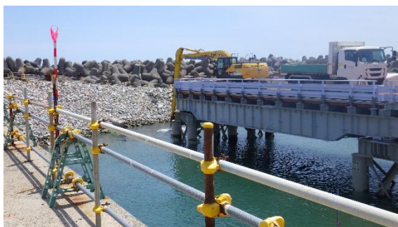
(写真 1—2) 浚渫作業の状況② (北側から撮影)
